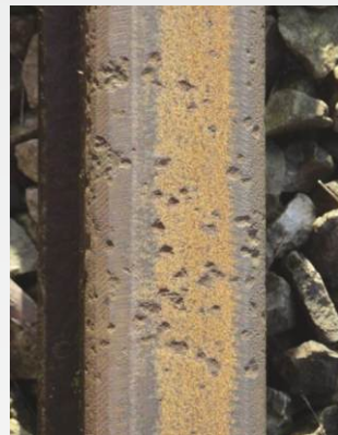
Kontaktní únava na temeni kolejnice a její zobrazení pomocí softwaru
