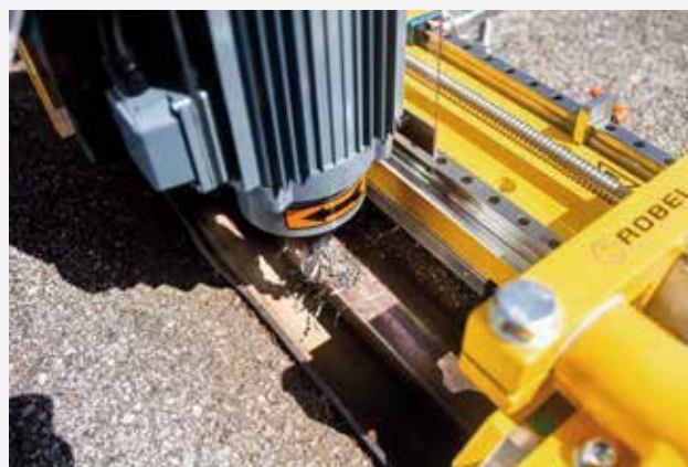
Odvodňovací drážka zhotovená frézou ROFACE
